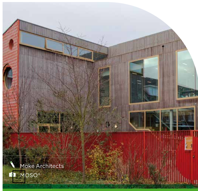
Basisschool IKC de Zeven Zeeën foto 5 jaar na installatie - (320 m 2 ) Amsterdam, Nederland
